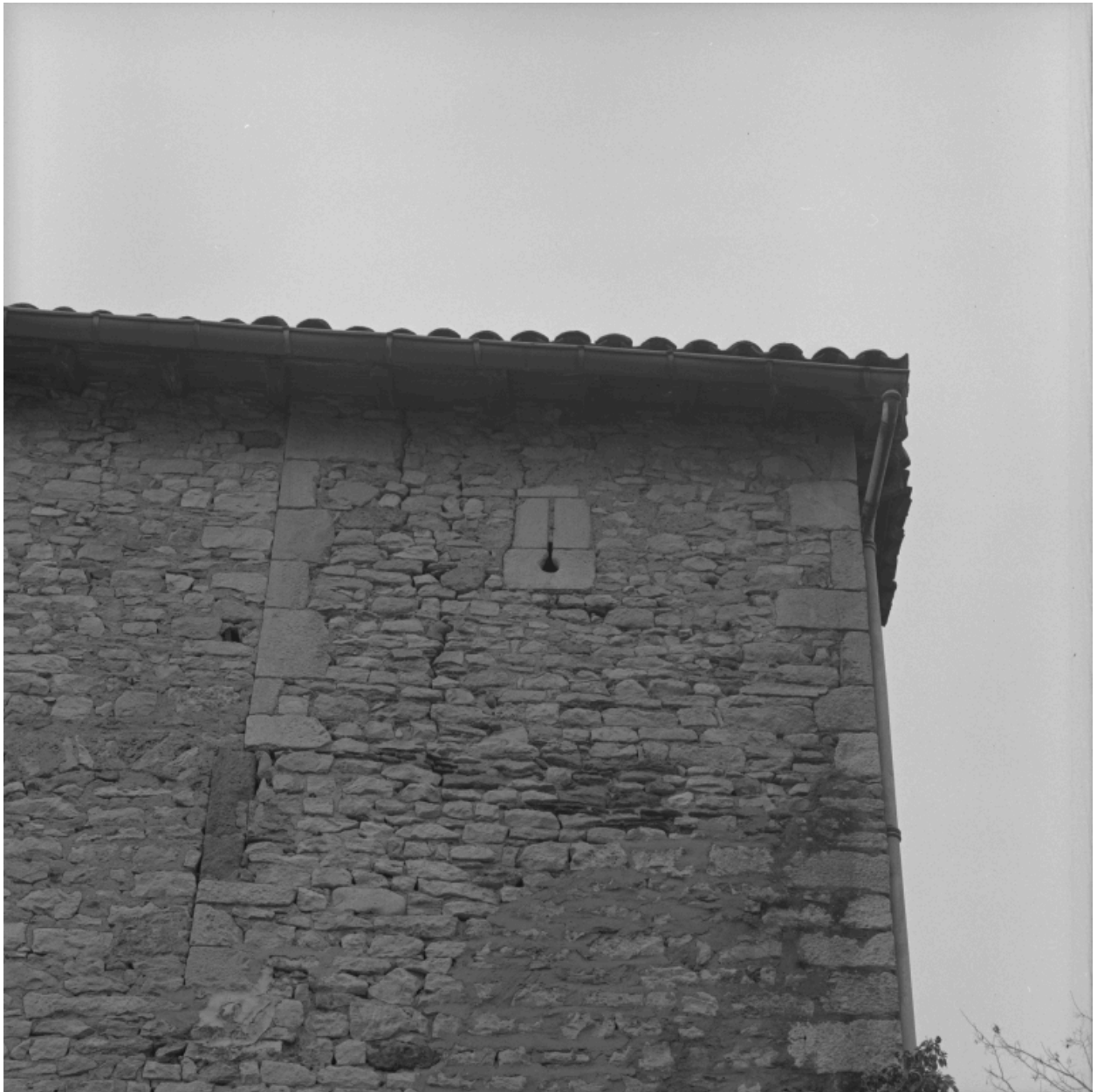
Élévation antérieure du corps de logis, détail : ancienne tour sud-ouest avec archère-canonnière.
