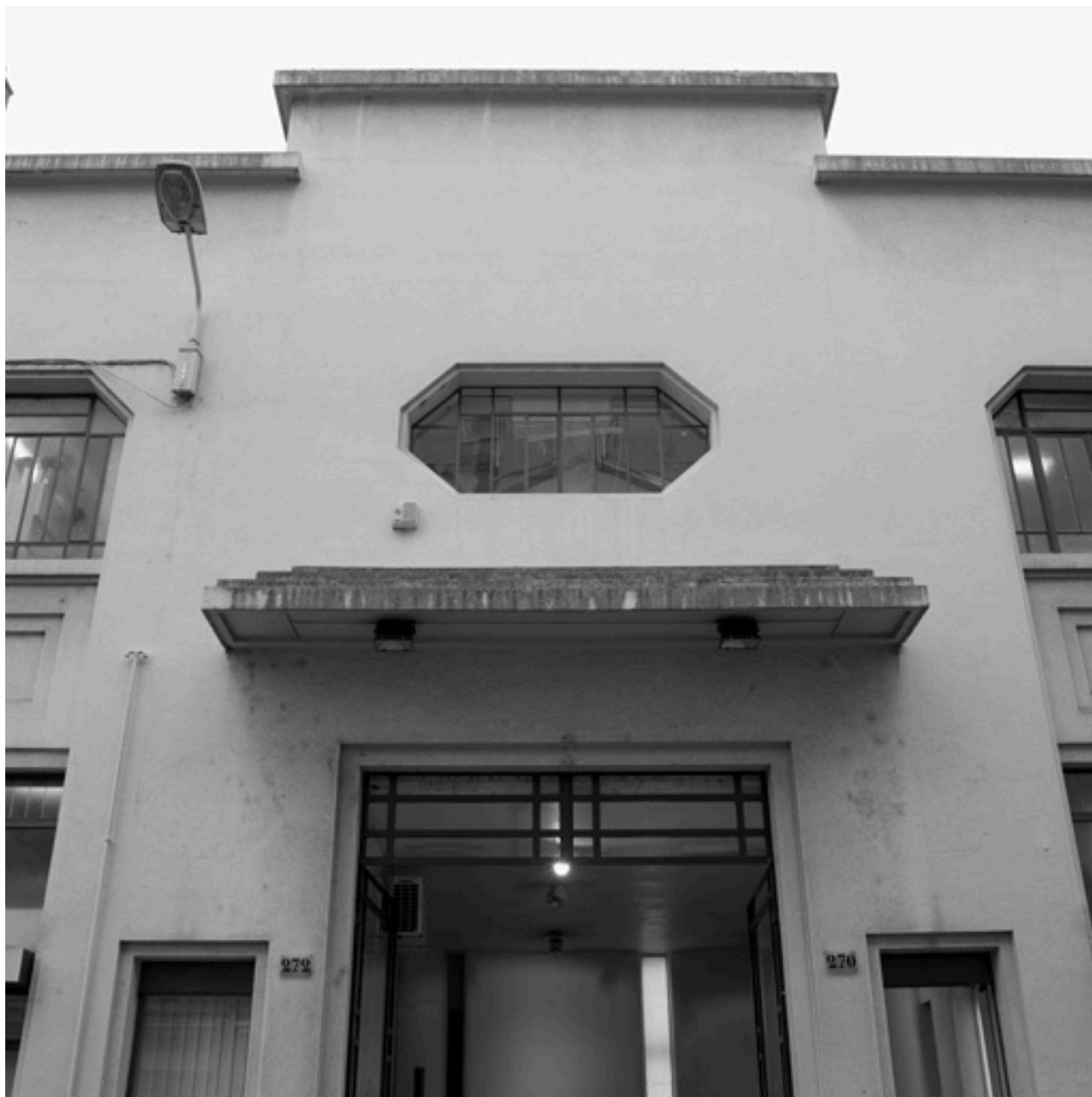
Oculus octogonale, et petit auvent en béton
