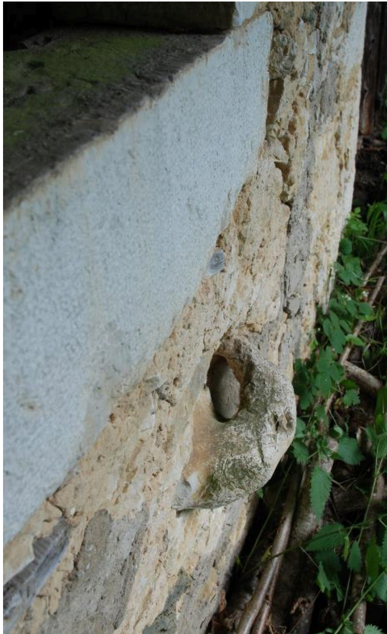
Détail de la façade principale : anneau en pierre.
