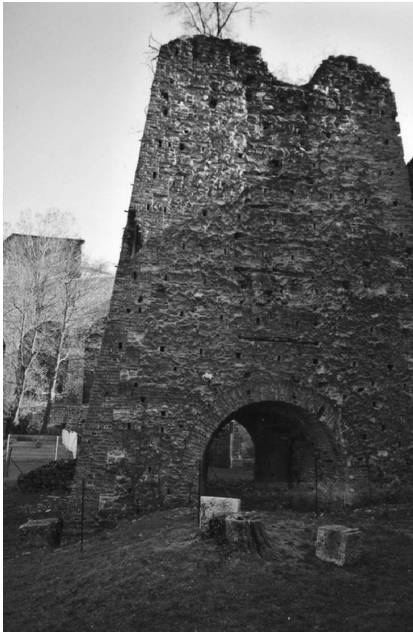
Détail sud haut fourneau
