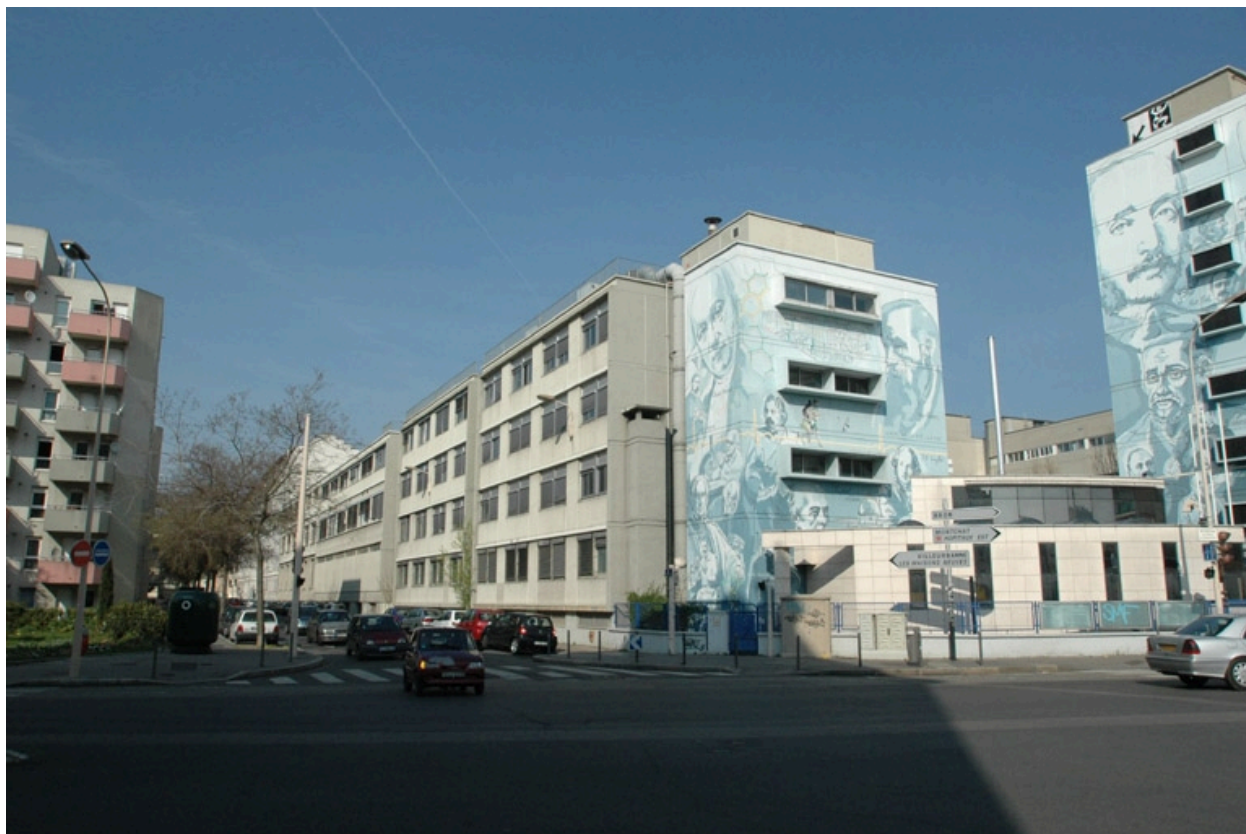
Vue sud des laboratoires
