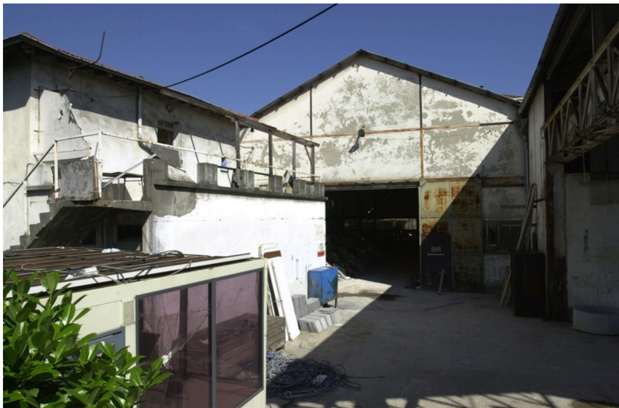
Vue de la cour depuis l'immeuble voisin
