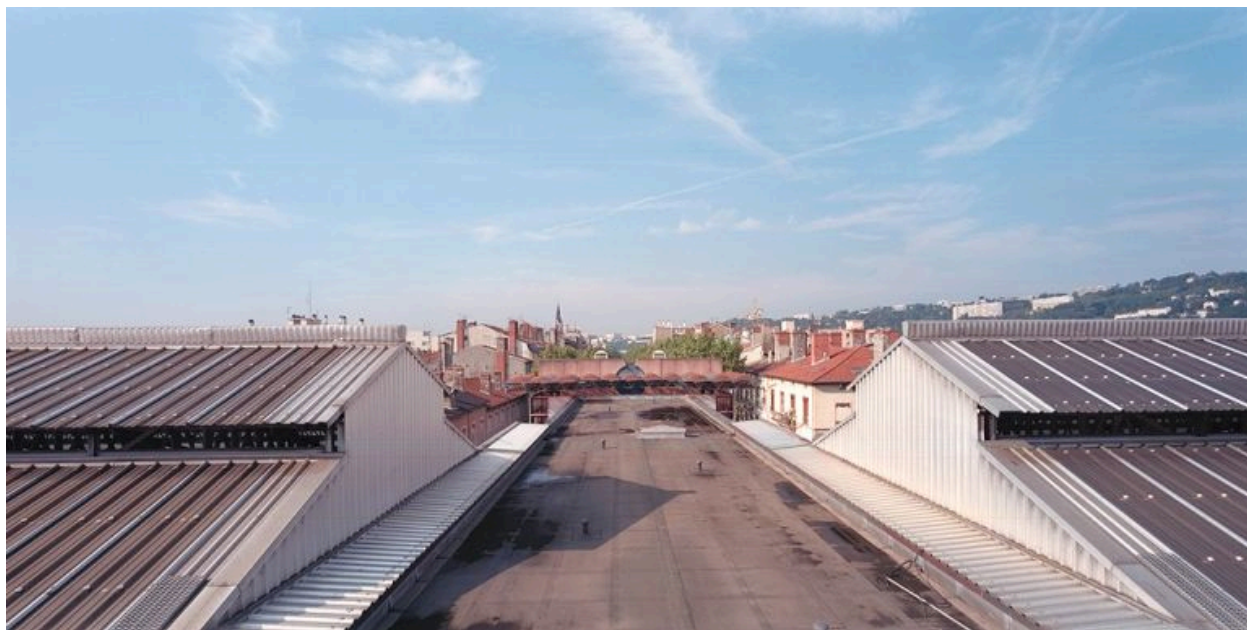
Vue d'ensemble du cours depuis le toit de la passerelle au nord
