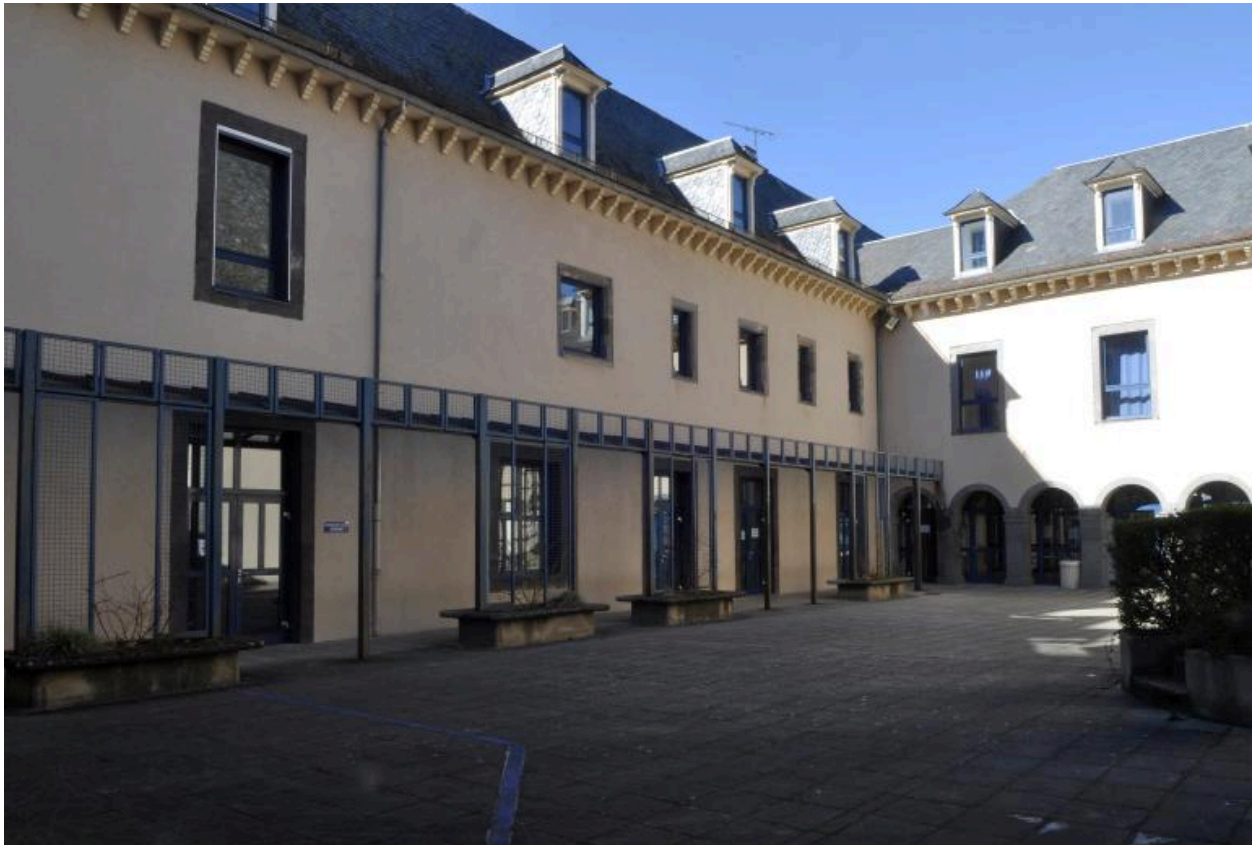
Cour sud, vue depuis le sud-est
