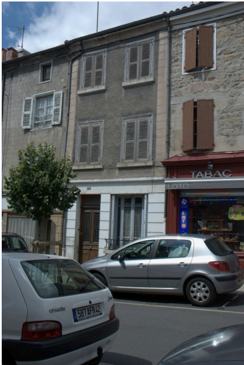
Îlot 4. République (place de la) 24. Vue générale de la façade sur la place.
