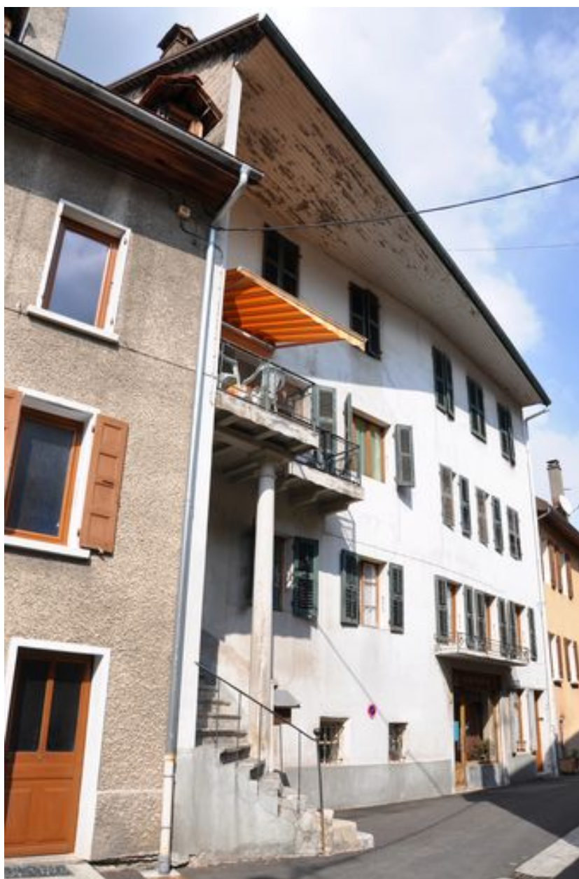
Façade antérieure de l'ancienne tannerie Neyret
