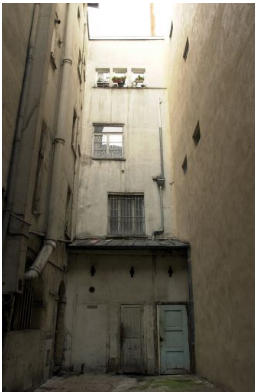
Grande cour I, revers du bâtiment longeant la rue Longue
