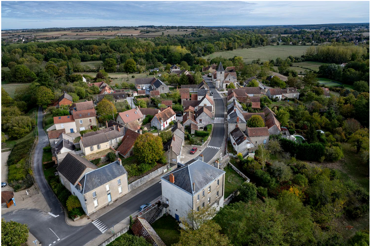
La mairie-école au premier plan au centre (prise de vue par drone, du nord-ouest).
