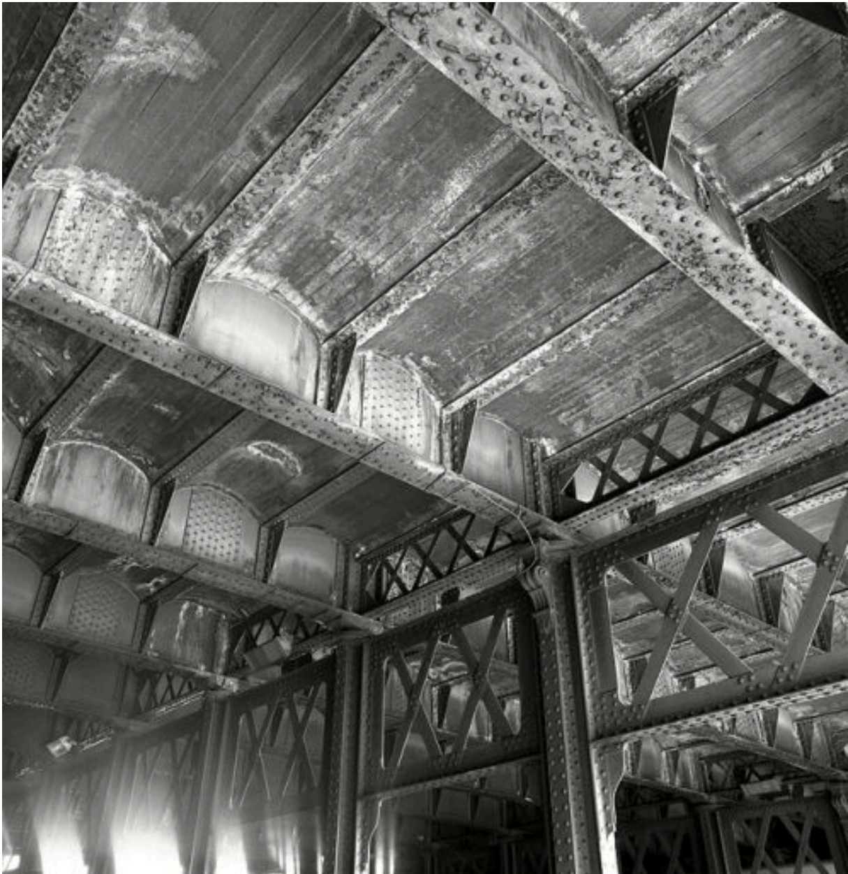
Travée de rive sur le quai Perrache : détail des voûtains du tablier
