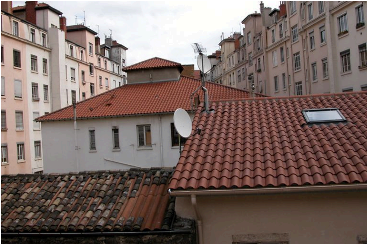
Vue du toit terrasse des dépendances côté est
