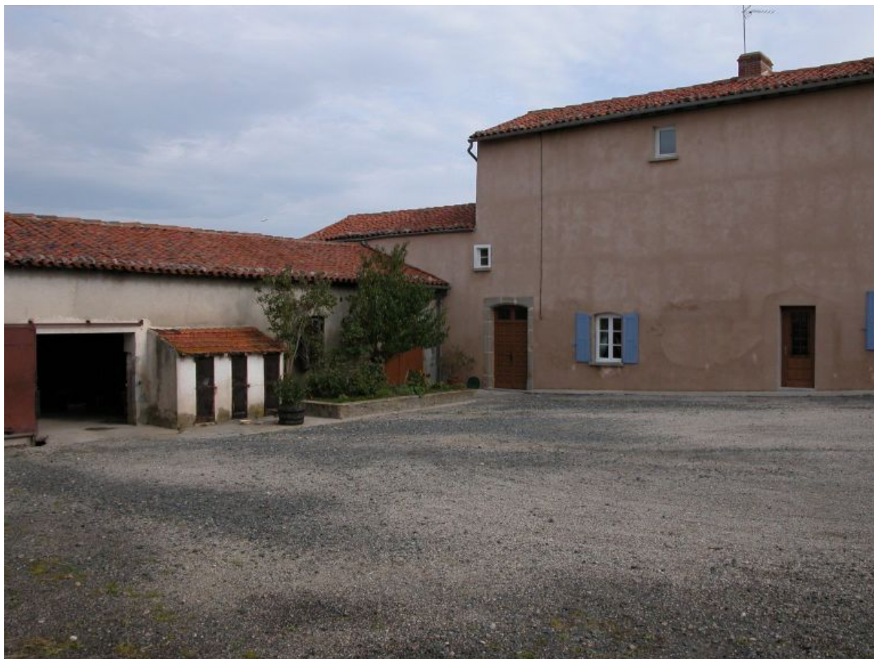
Angle nord-est de la ferme (logis et communs)
