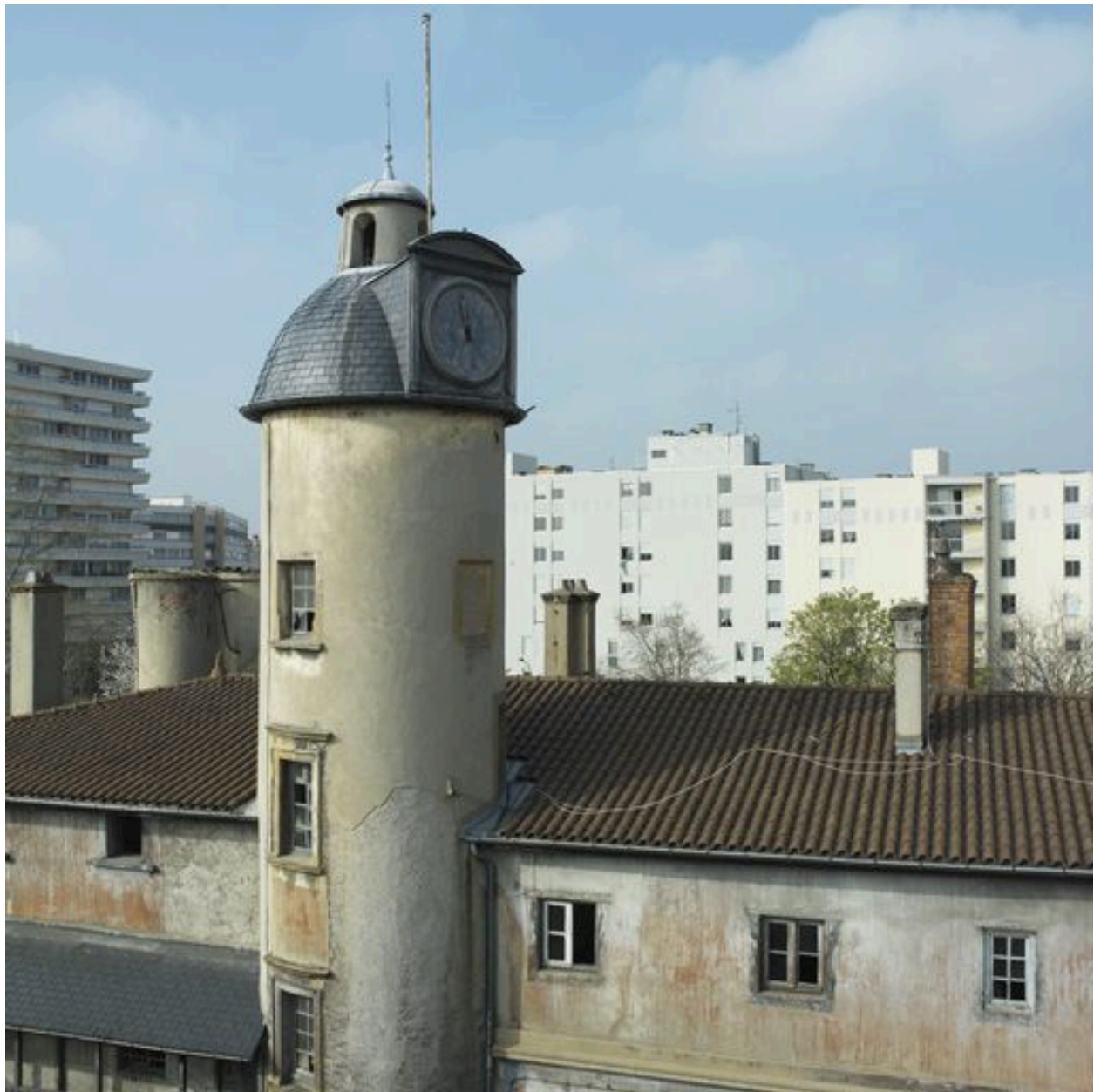
La tour d'escalier depuis le nord-est et l'horloge
