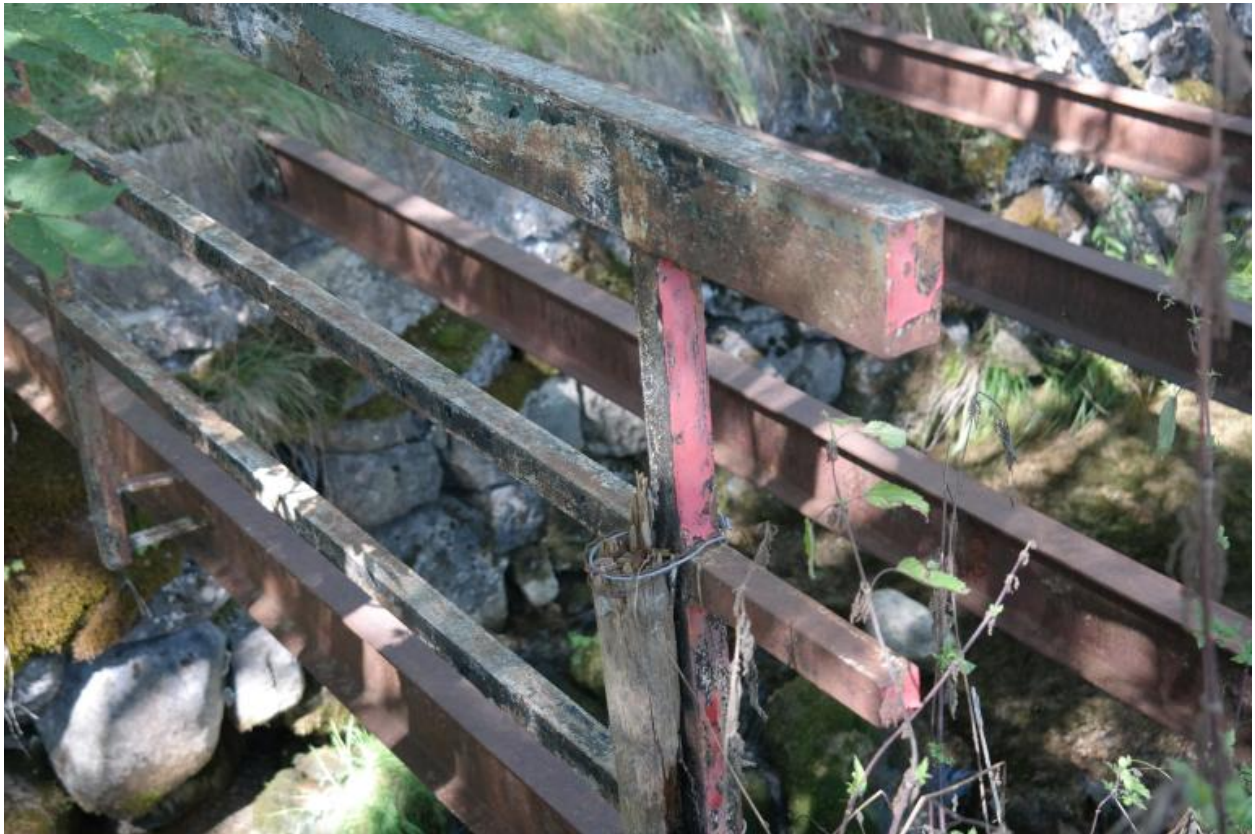
Passerelle de la Chapelle d'Abondance, détail structure
