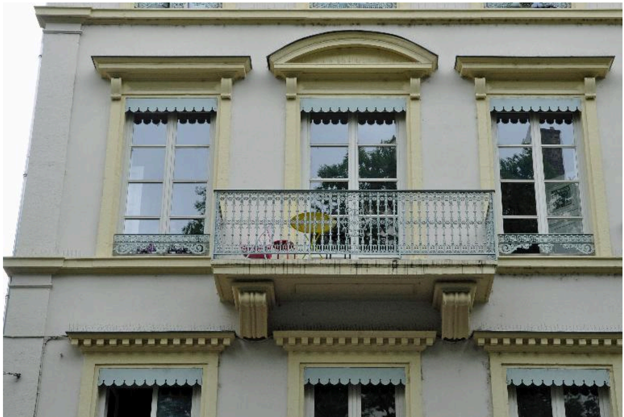
Vue rapprochée de l'élévation sur place : fenêtres et balcon du 2e étage carré
