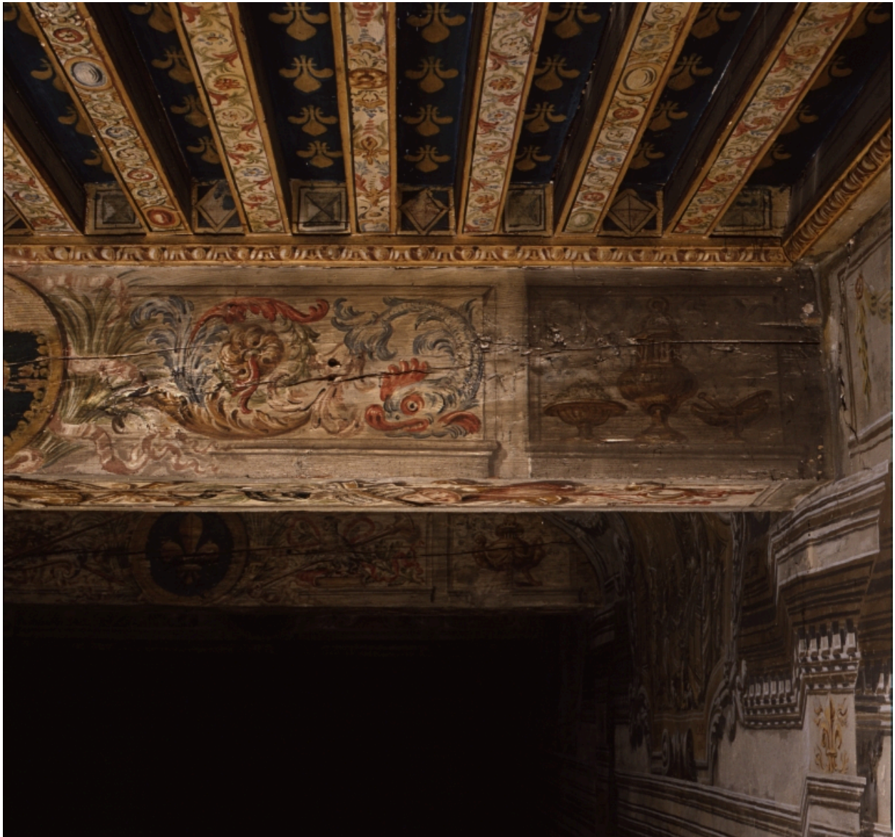
Poutre 2, face nord, extrémité droite : rinceau peuplé de dauphins.
