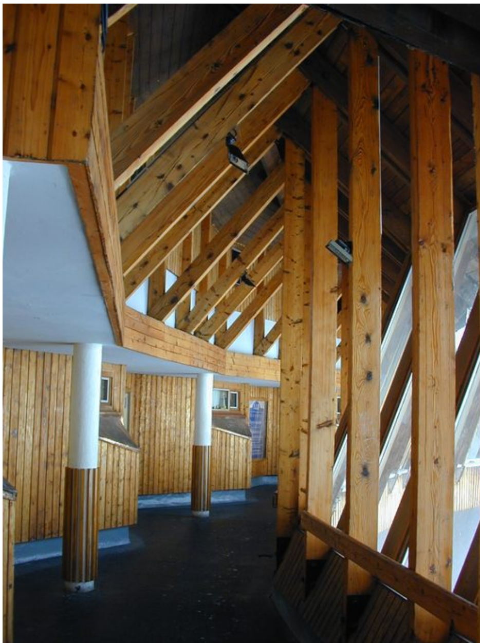
Vue d'ensemble de la coursive publique
