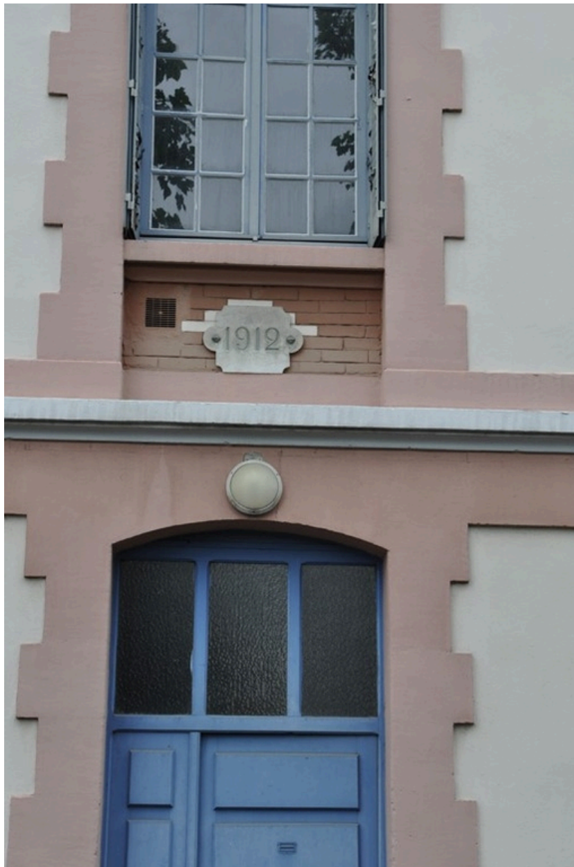
Bâtiment 1912 date portée façade est
