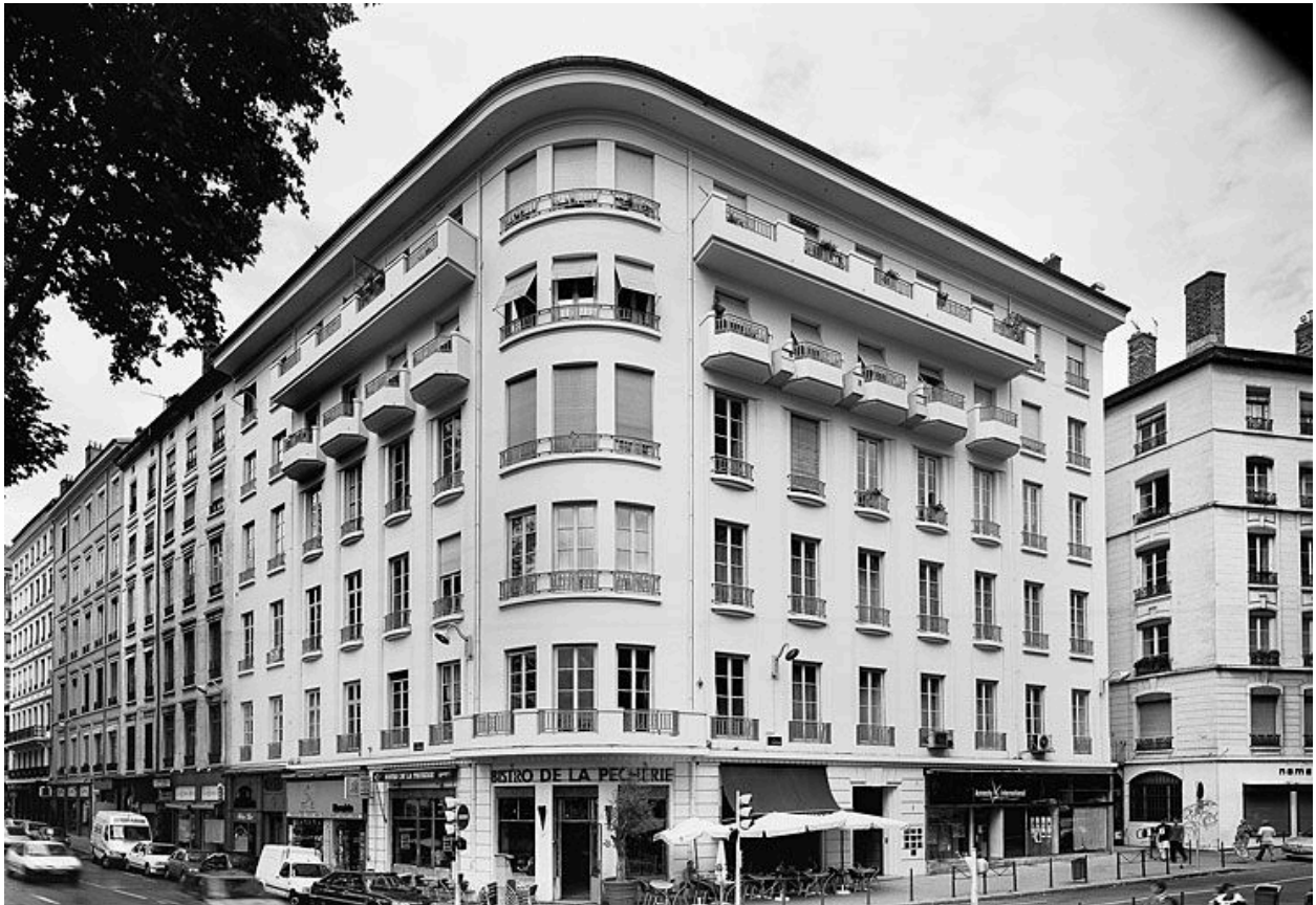
Vue générale des façades
