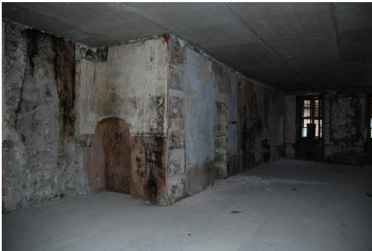
Vue intérieure du 2e étage : pièce nord, vue depuis le sud.
