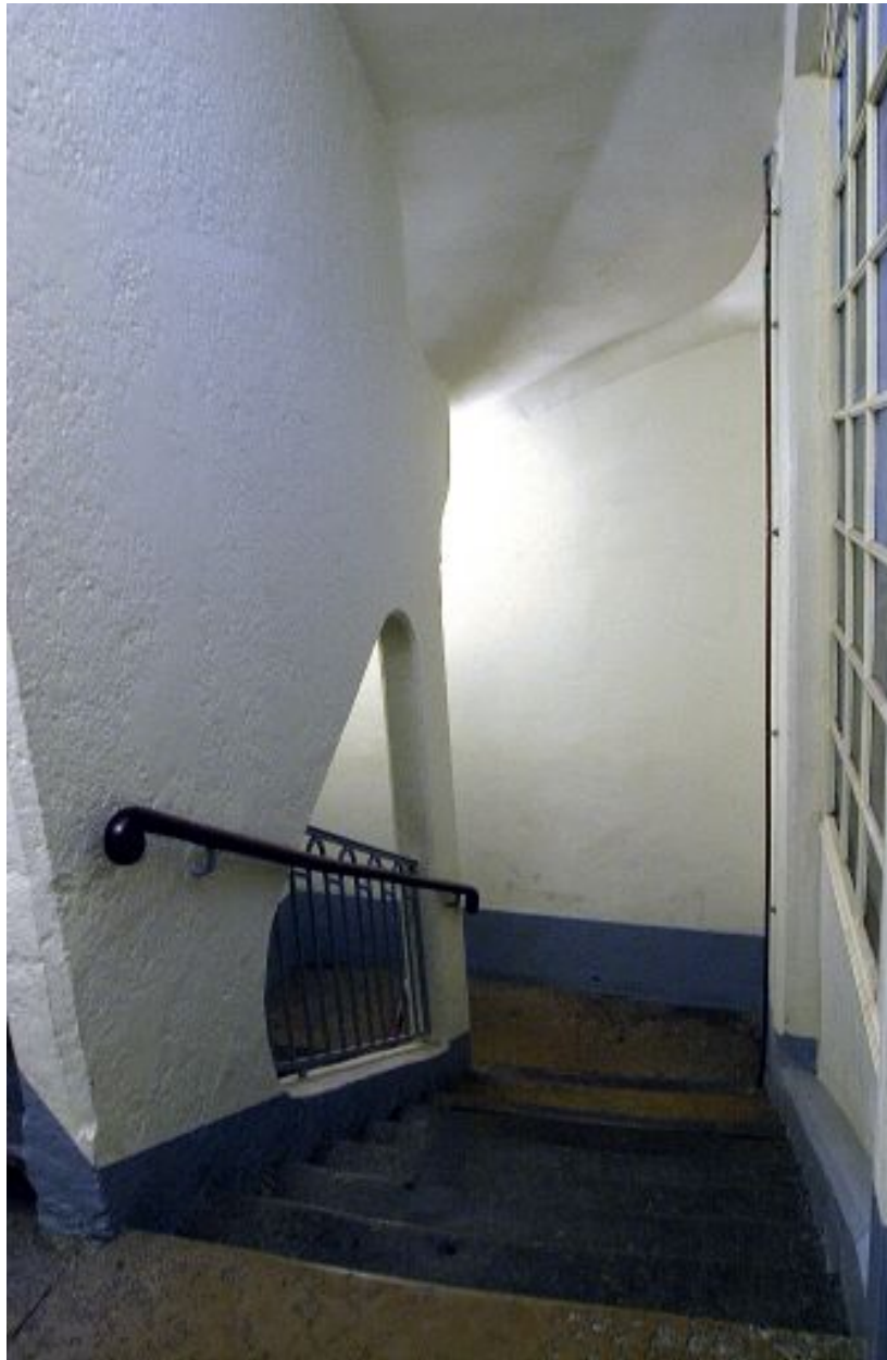
Escalier, mur noyau ajouré
