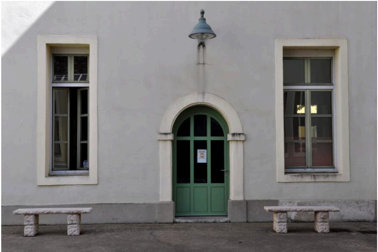
Bâtiment D : entrée d'une ancienne salle de classe
