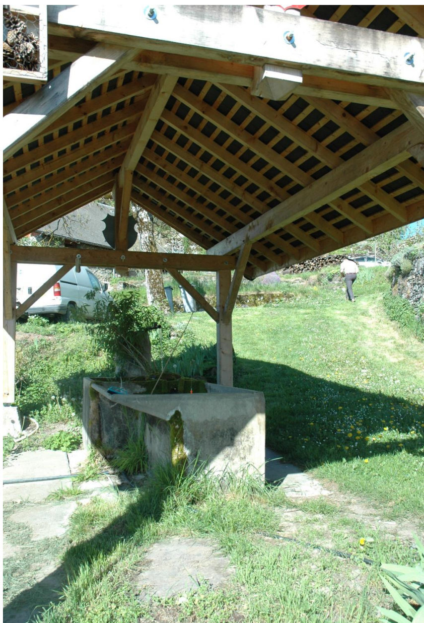
Mont-Benoît-dessus. Vue du bassin couvert (2018 ZA 151).
