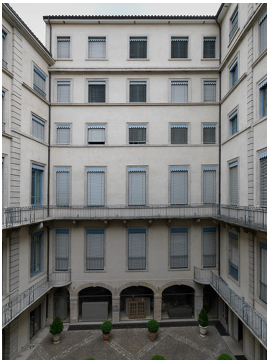
Vue de l'élévation nord de la cour
