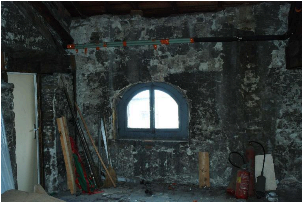
Cour d'honneur, corps de bâtiment est : comble, détail d'une baie
