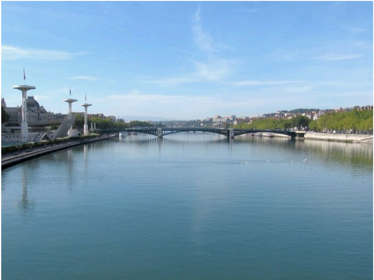
Vue générale, face amont (depuis le pont de la Guillotière)
