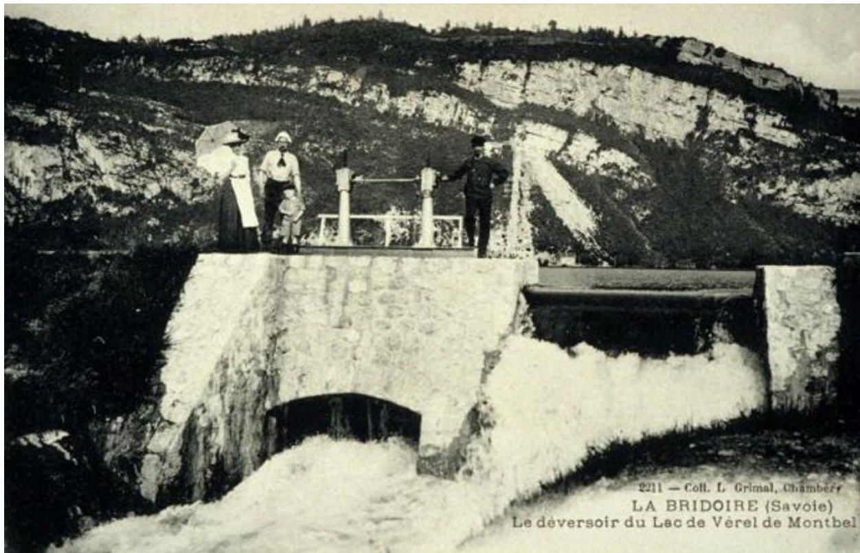
Vue ancienne du déversoir du bassin de démodulation de la centrale (© Collections et clichés Musée Savoisien).
