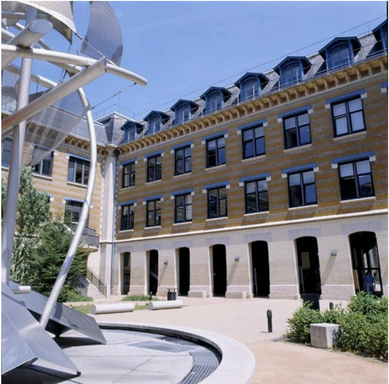
Vue de la cour nord
