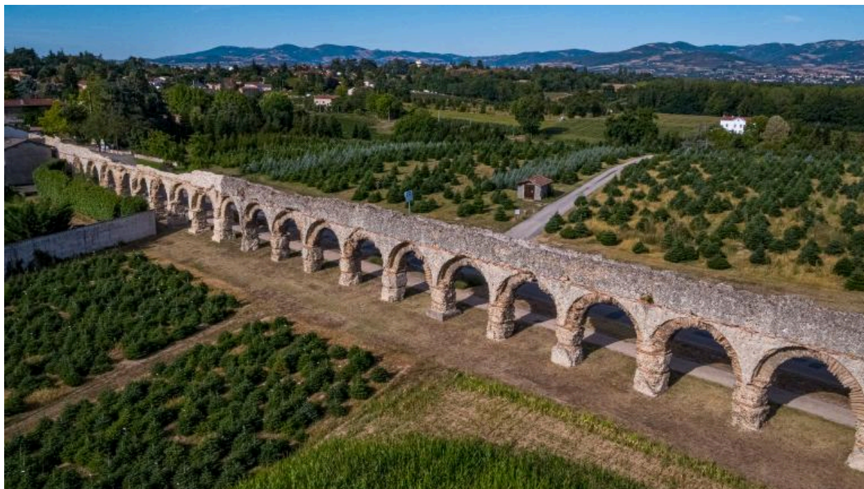
Vue d'ensemble de l'aqueduc du Gier à Chaponost (drône)
