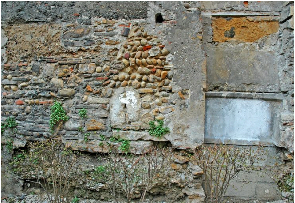
Mur mitoyen sud de la cour en pisé galet et machefer dans la partie supérieure
