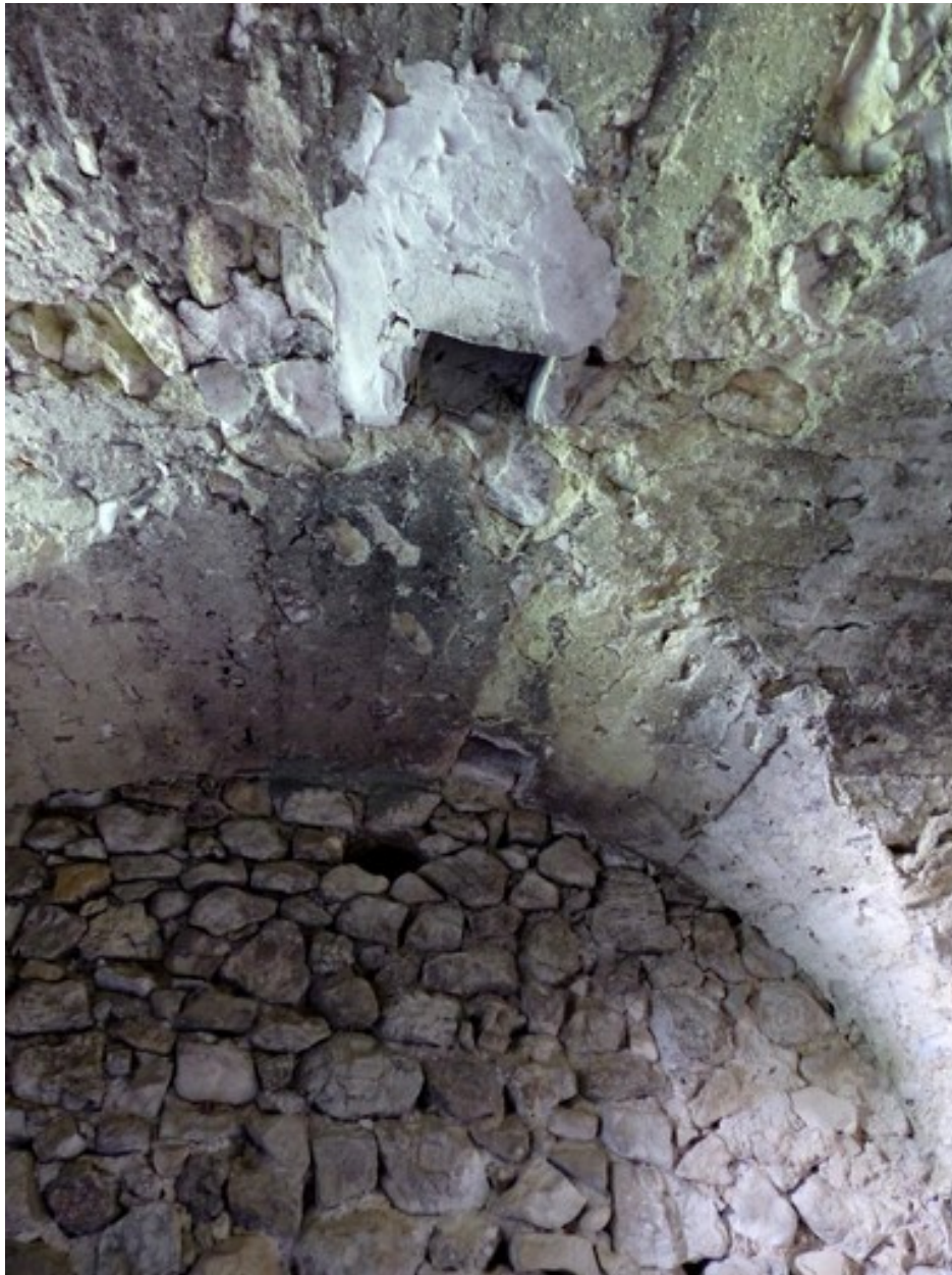
Dépendance sud-ouest. Etage de soubassement, cellier. Travée sud, trappes.
