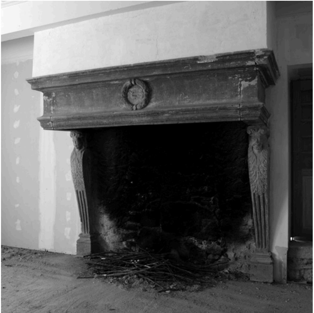
Vue d'ensemble de la cheminée de la salle ouest.
