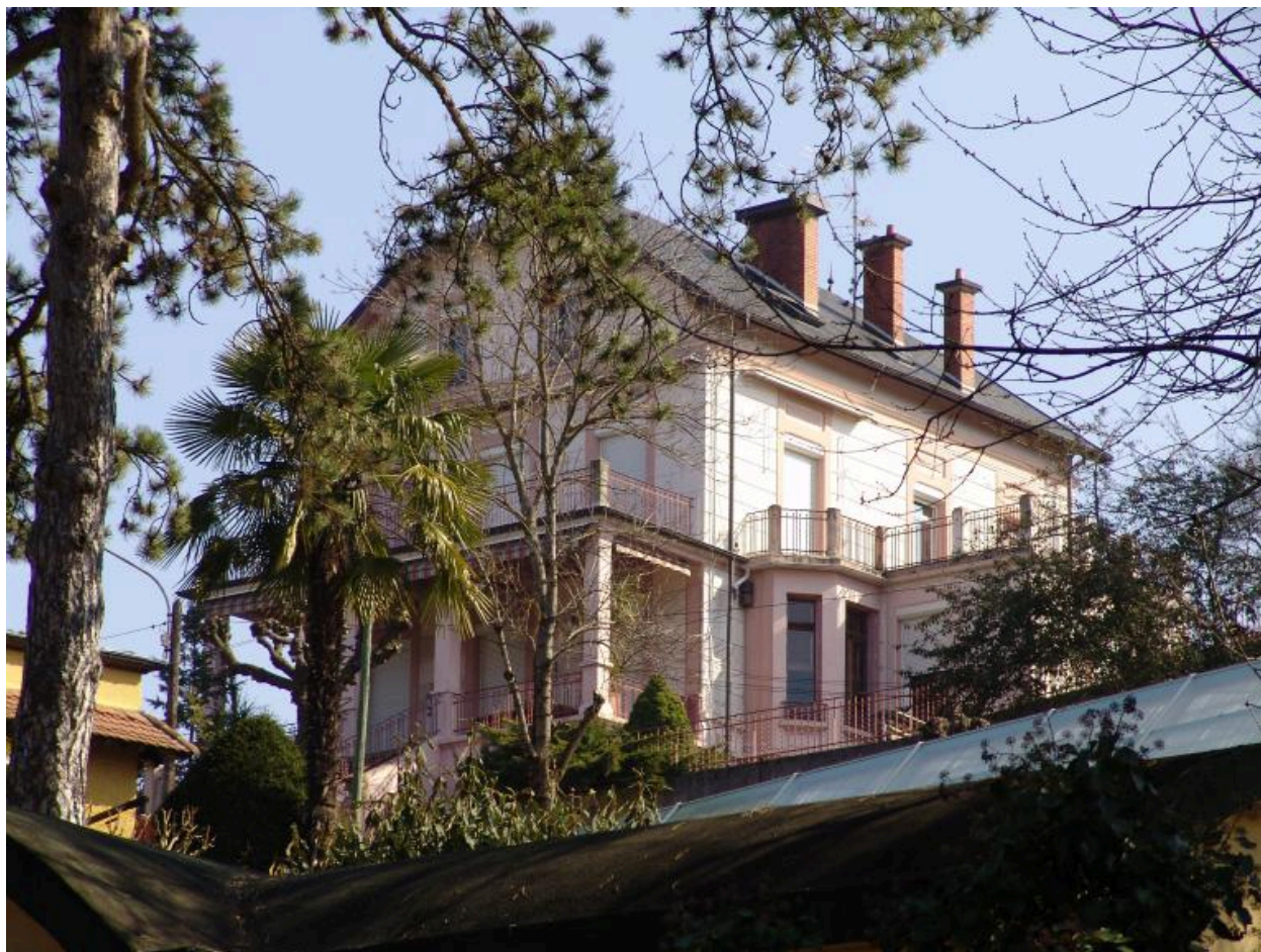
Vue d'ensemble depuis le boulevard
