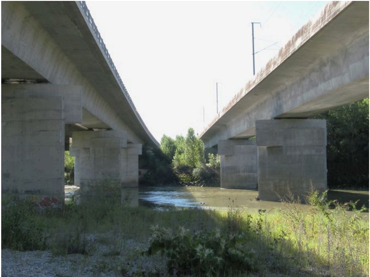
Vue des tabliers des deux ponts ferroviaire et autoroutier (à droite sur la photo) juxtaposés, parties franchissant le canal de Miribel (depuis la rive droite)
