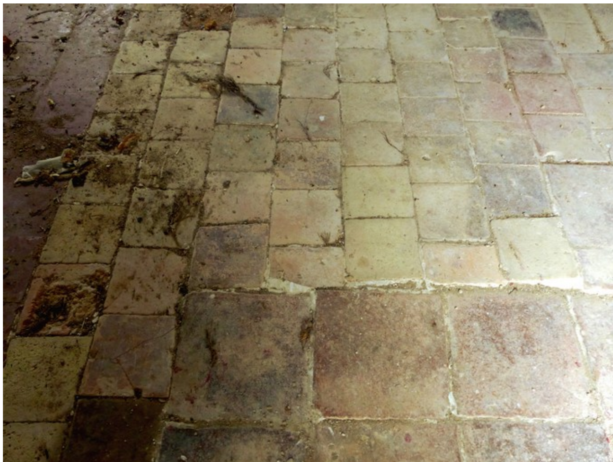
Sol en carreaux de terre cuite de différentes factures, ferme au quartier de Bigonnet.
