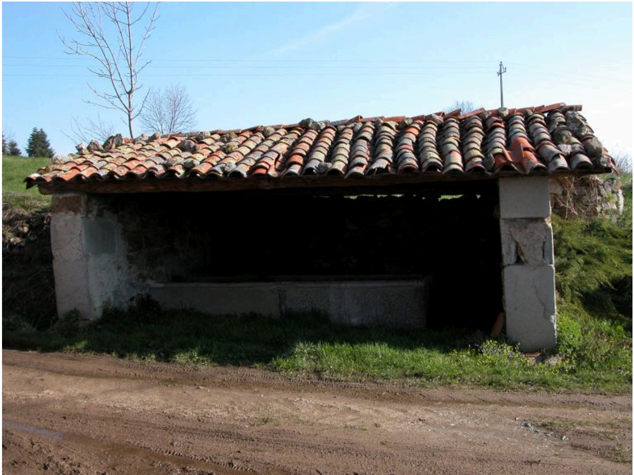
Maisonny (le), G2 426. Vue d'ensemble d'un bassin.
