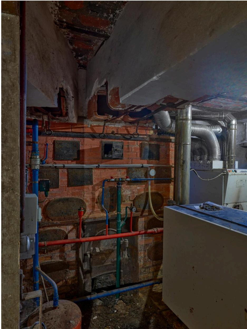
Vue du corps de chauffe du chauffage central à air pulsé situé en sous-sol.
