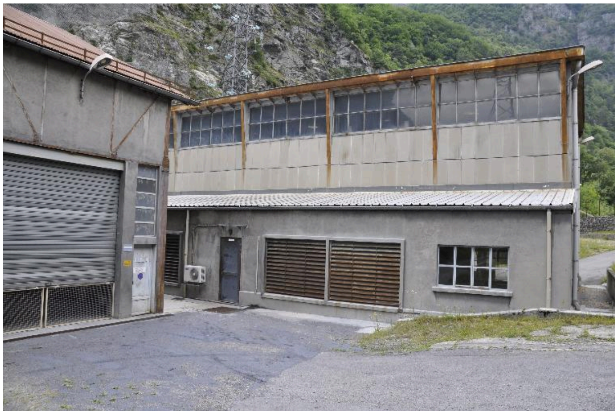
Vue de la centrale Pierre-Eybesse III
