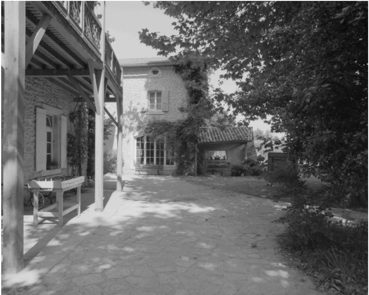
Le Béal. Moulinage. Vue partielle de l'orangerie.
