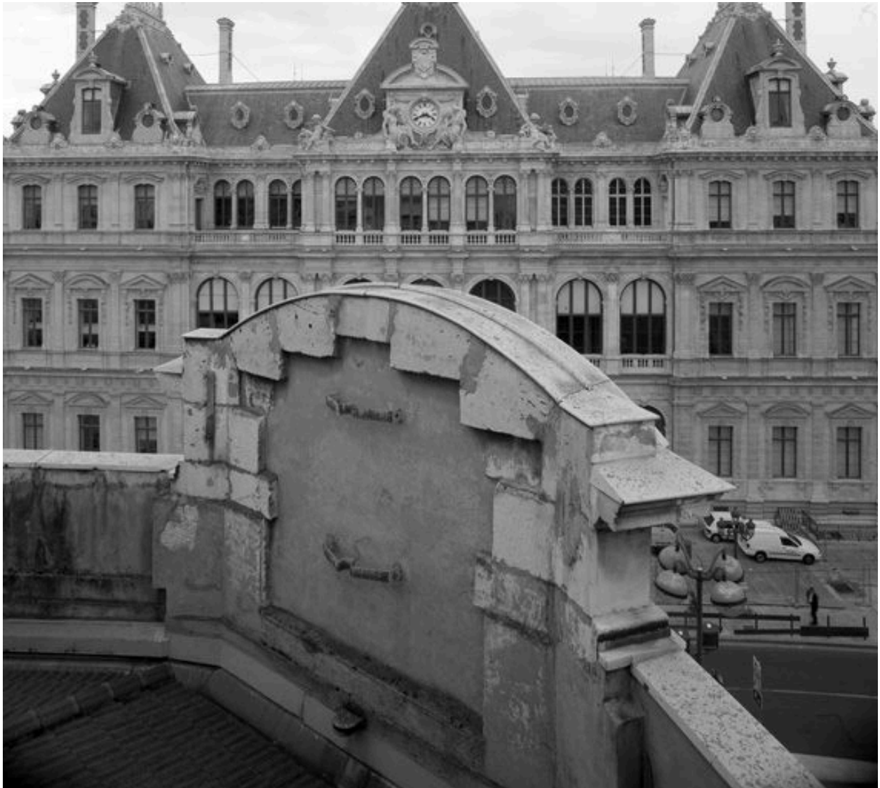
Détail du fronton de l'angle nord-est, élévation postérieure
