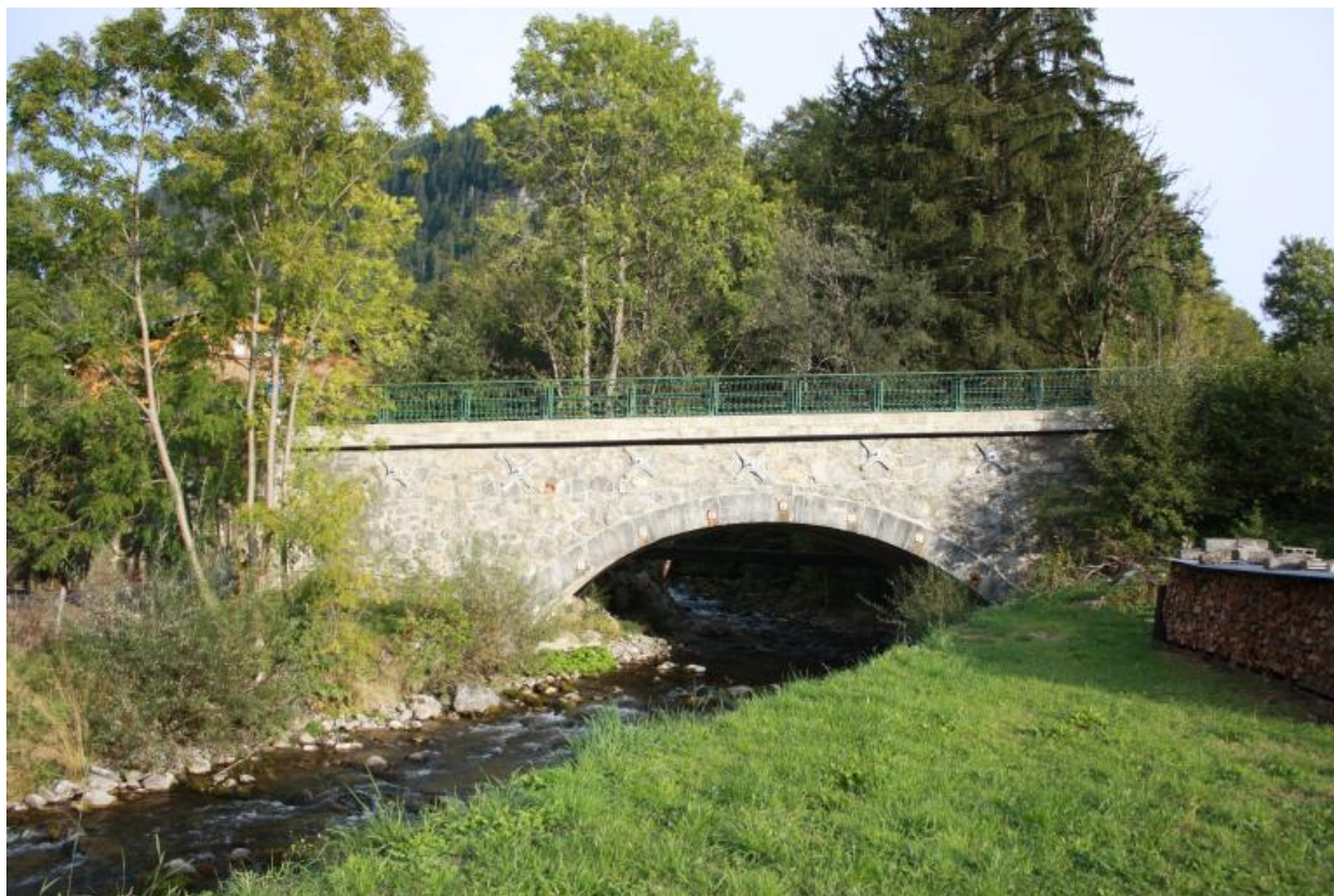
Vue générale du pont de la Glières
