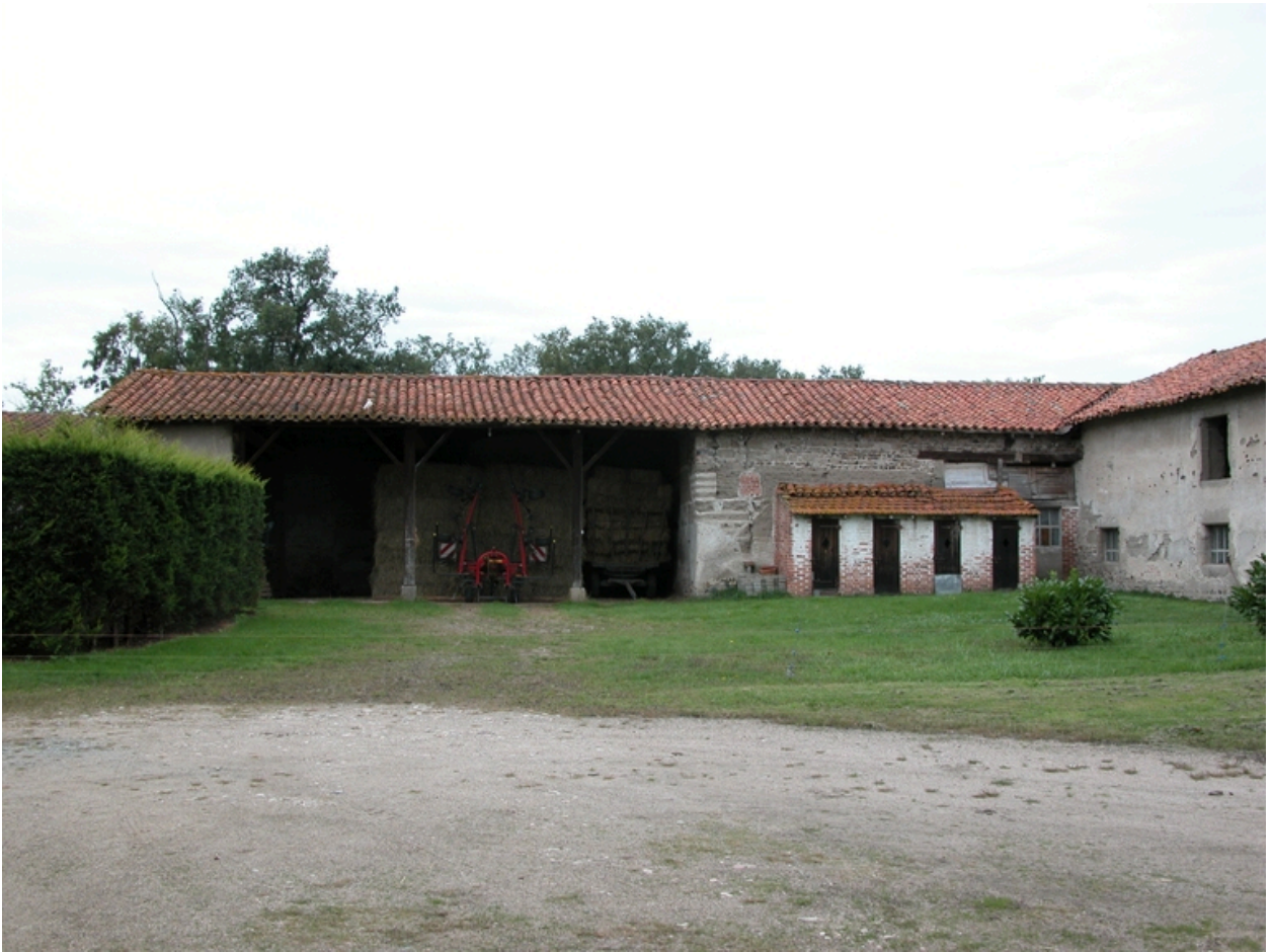
Vue du bâtiment ouest : étable, hangar.
