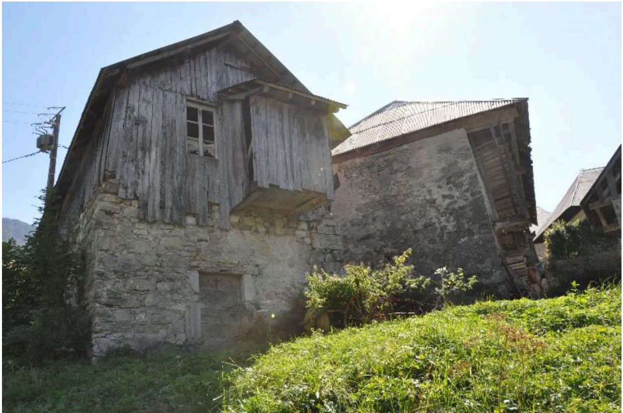
Vue du pignon nord de la scierie.
