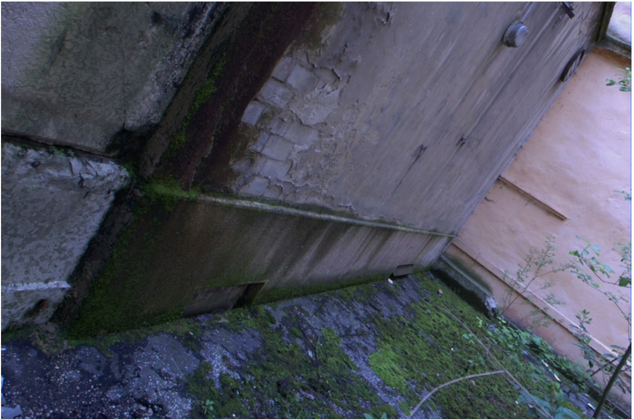
Détail ouest souterrain
