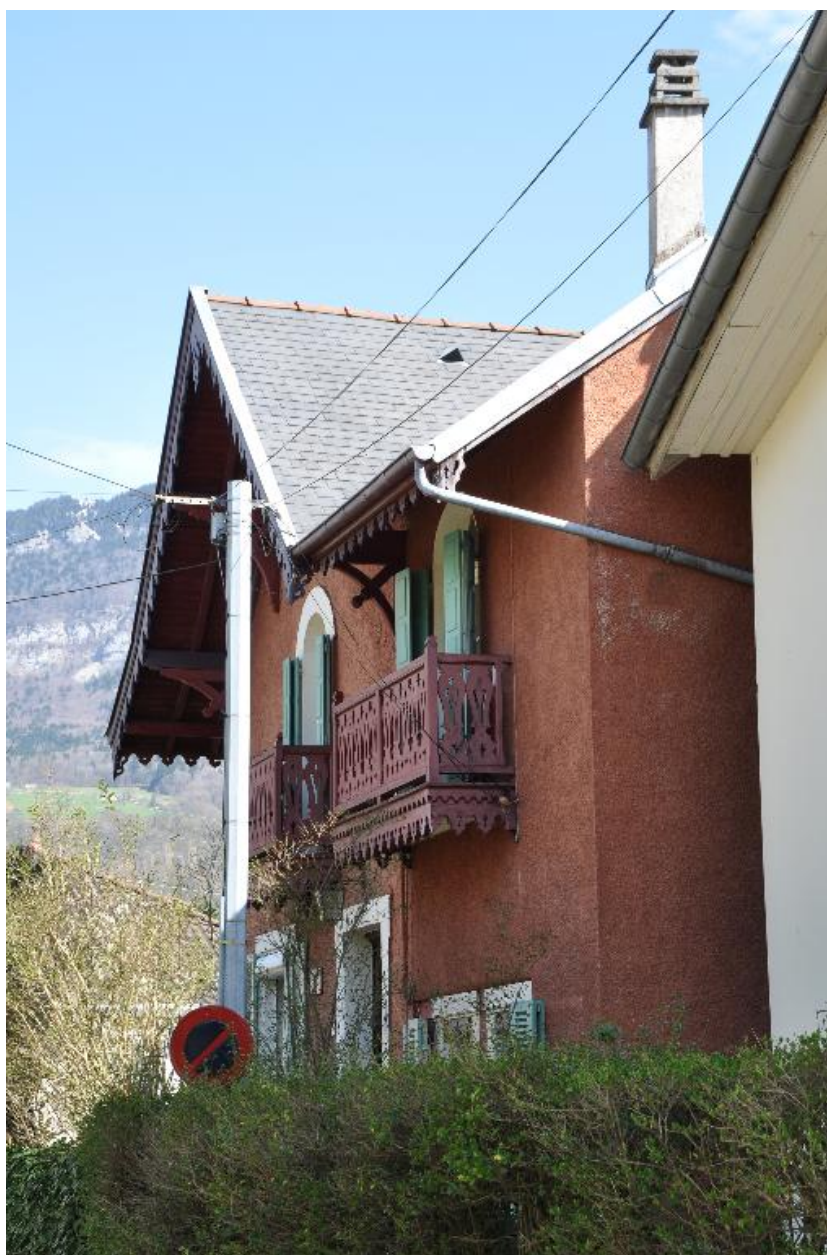
Détail sur les garde-corps des balcons en bois découpé
