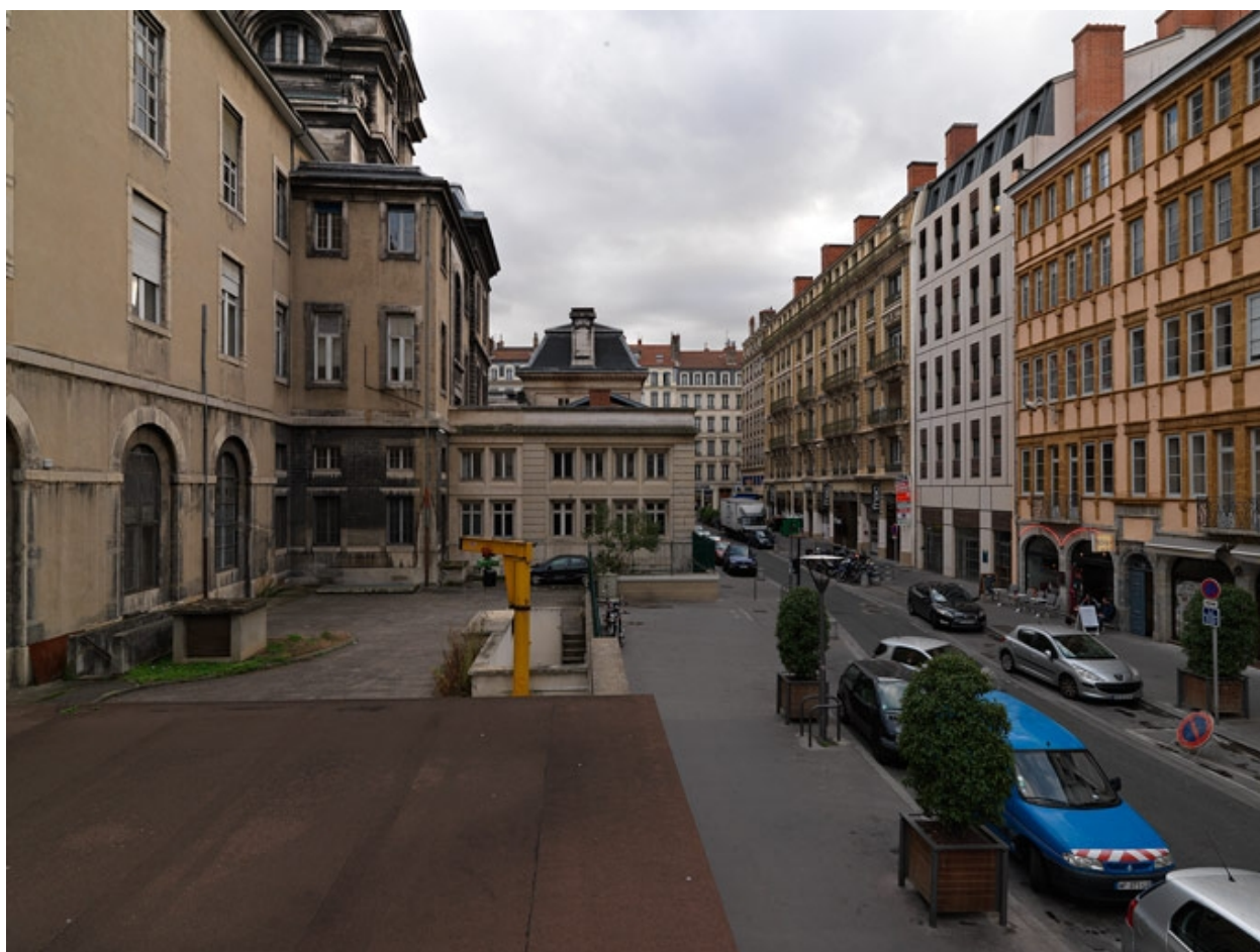
Bâtiment D. Elévation nord
