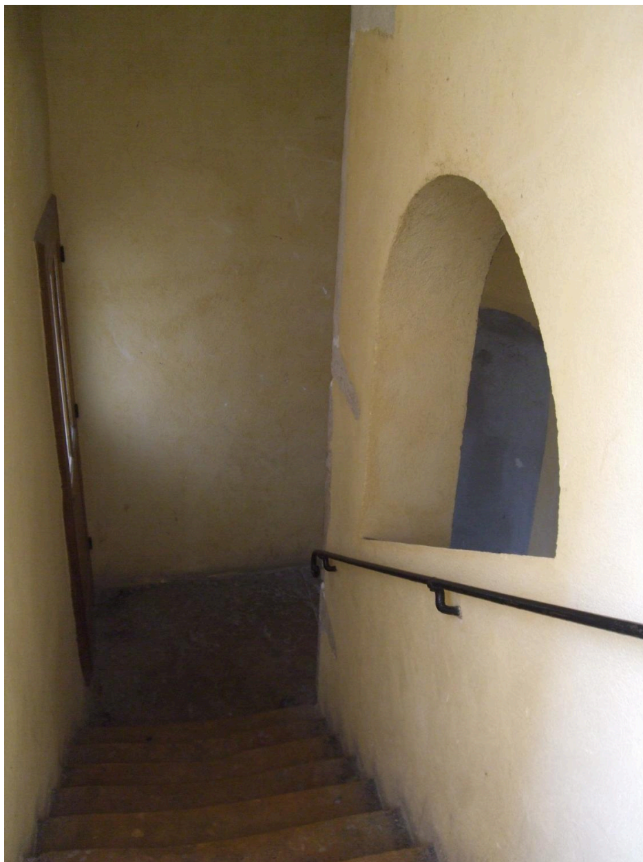
Baie demi-circulaire dans le mur noyau
